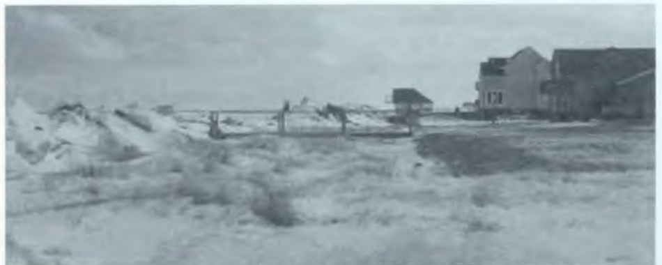
La photo ci-dessus montre le pont de Bouctouche. La photo a été prise proche de l'heure de marée haute le 26 janvier. On voit clairement la pointe de ligne d'eau sur le pieu de ciment. La photo du bas a été prise près de Barachois et montre à quel point les glaces empilées se sont rapprochées des résidents dans un nouveau lotissement rapproché des rives.
