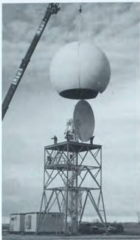
Le radar Doppler de Woodlands en construction.
