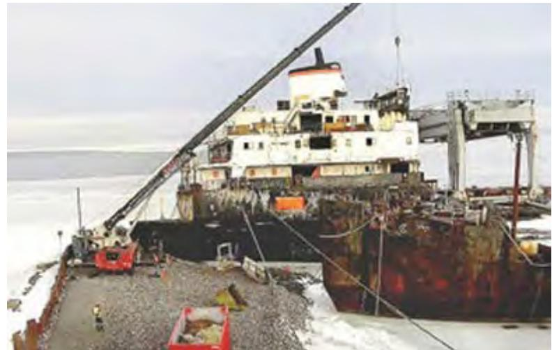
*Le démantèlement du Kathryn Spirit a débuté il y a quelques semaines. L'opération de découpage - en cours sur la photo - permettra de récupérer le métal à des fins de revente*
